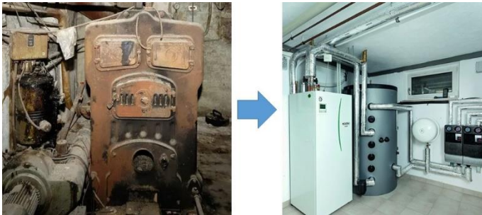
Abbildung: Ersatz einer veralteten Ölheizung durch eine moderne Wärmepumpe
